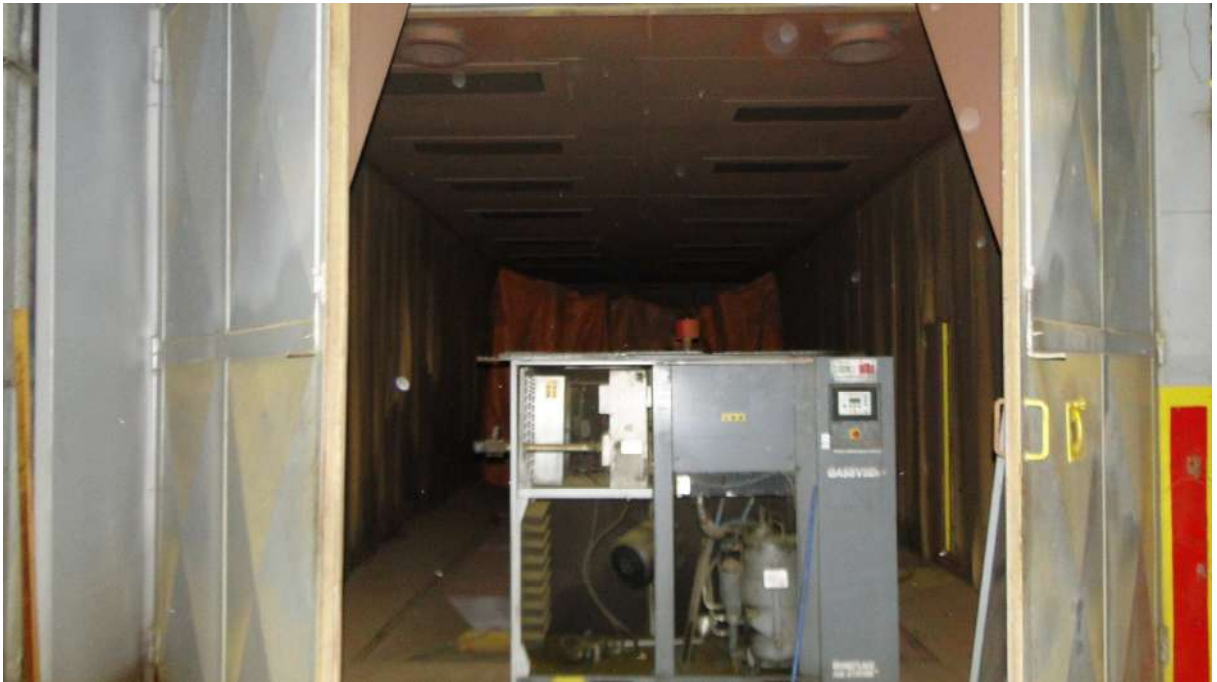
Foto 14: Cabine de Pintura a Pó (item 58)
