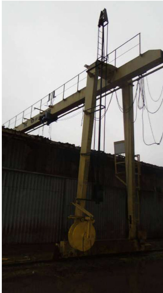
Foto 13: Pórtico 15 t (item 100)
