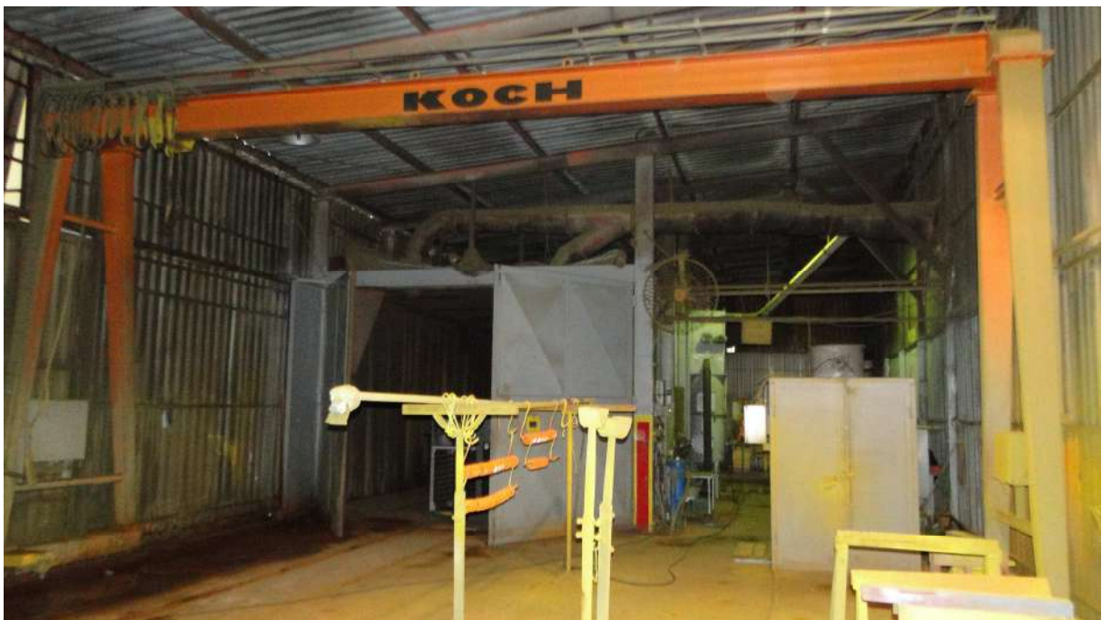
Foto 16: Pórtico 5 t (item 101)
