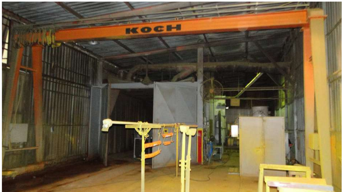
Foto 12: Foto interna do pavilhão 2
