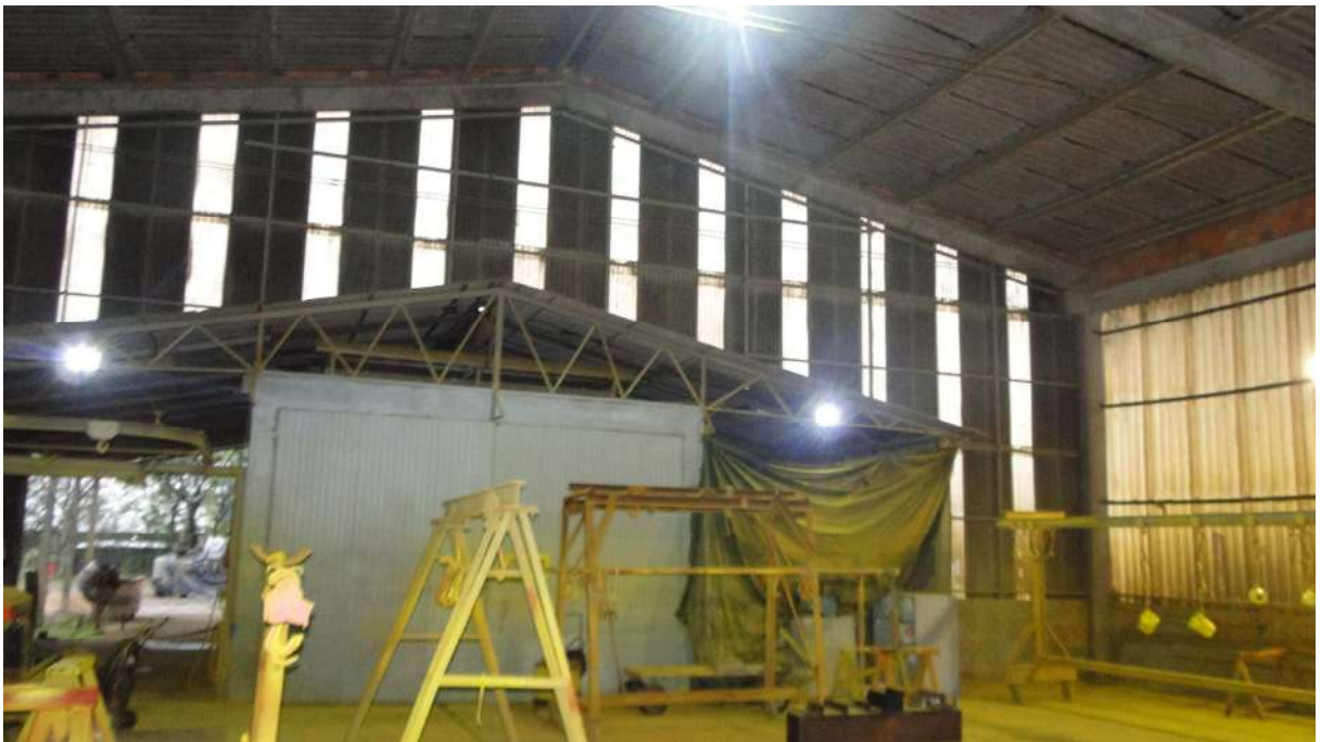
Foto 10: Foto interna do pavilhão 2
