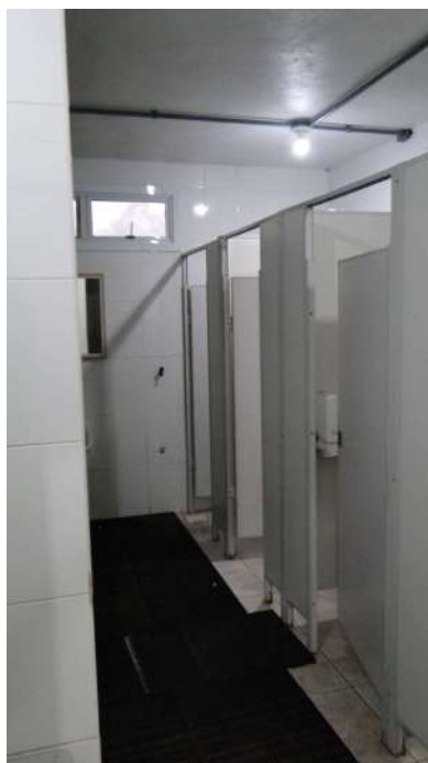
Foto 7: Detalhe banheiro masculino do pavilhão 1
