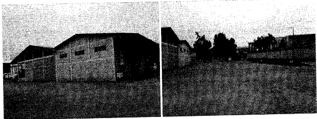
Vistas do Depósito de Produtos e do Pátio de Manobra Pavimentado
