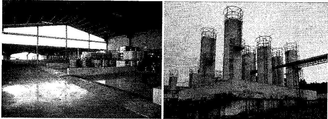
Vistas do Deposito de Corrosivos e dos Tanques de Armazenamento
